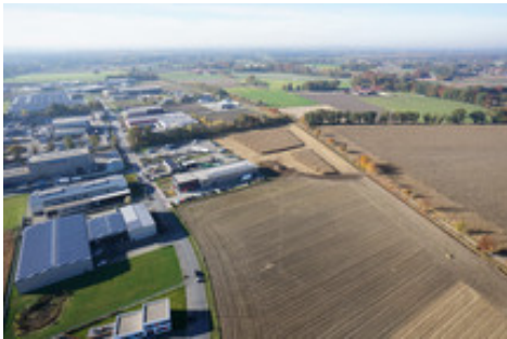
Luftbild Industriegebiet Süd-West Erweiterungsfläche Ostansicht
