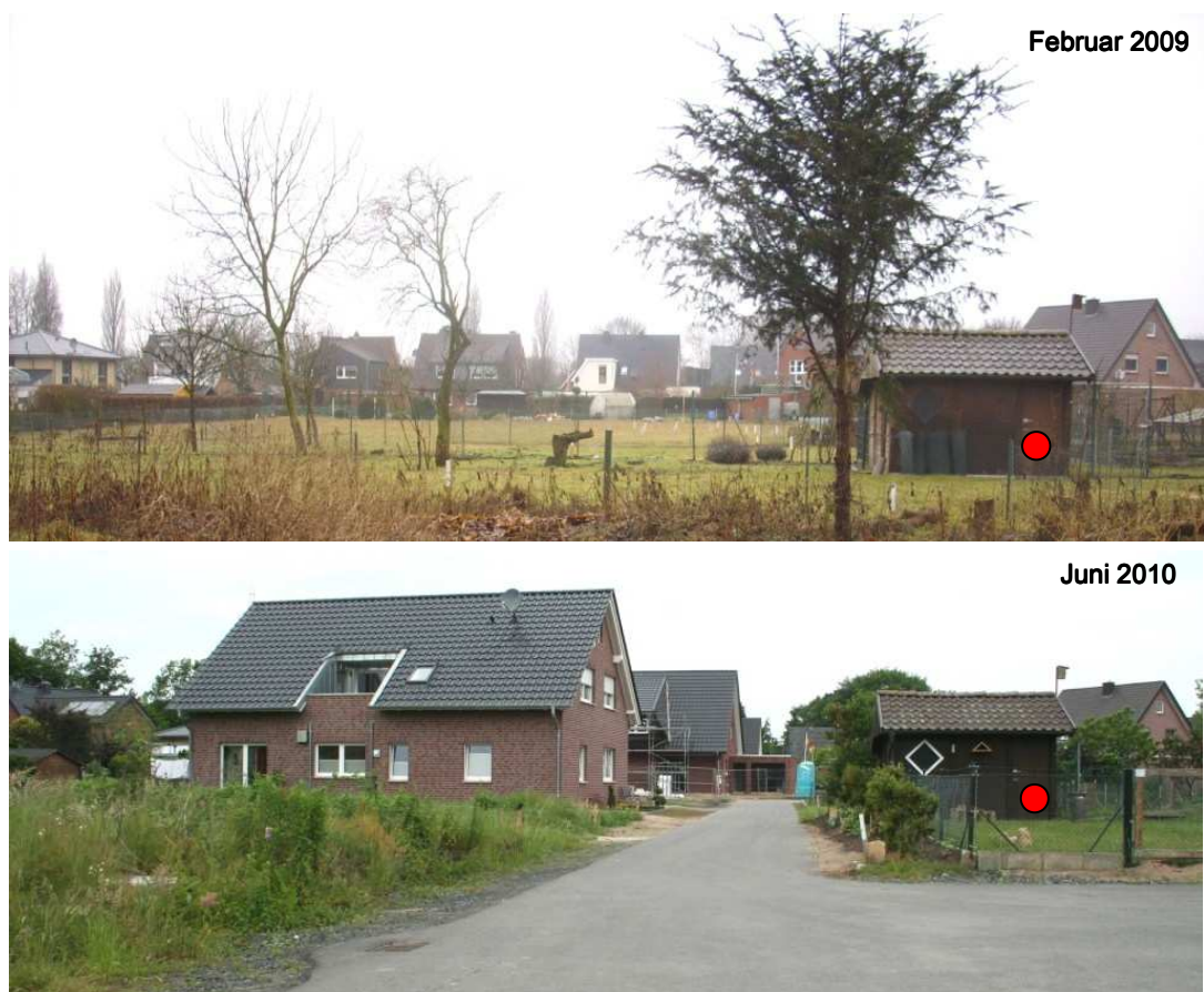
Abbildung 1: Baufortschritt im Modellbereich "Herzbach/Dreihuesweg"
