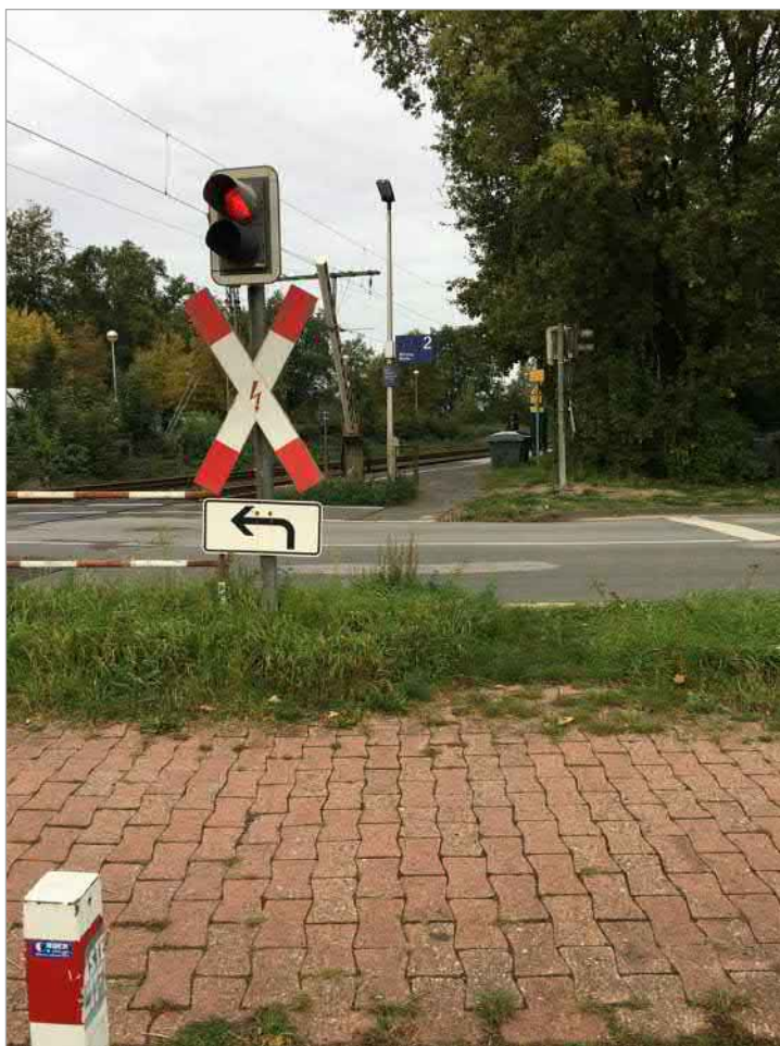
Abbildung 9: Fehlender Übergang für Zu-Fuß-Gehende
