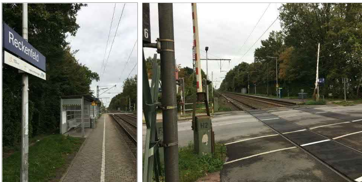
Abbildung 8: Links: Bahnhaltepunkt Greven-Reckenfeld (Blickrichtung Nord), rechts: Bahnübergang
