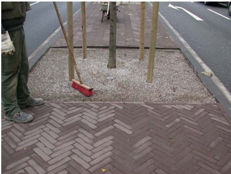
Baumscheiben mit Gitterrost (oben) und ungebundenem Aufbau (unten)
