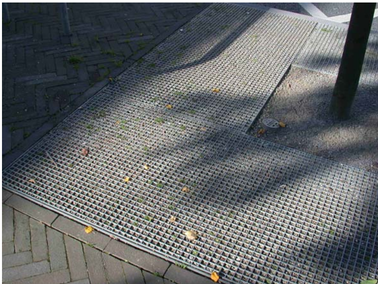
Baumscheiben mit Gitterrost (oben) und ungebundenem Aufbau (unten)
