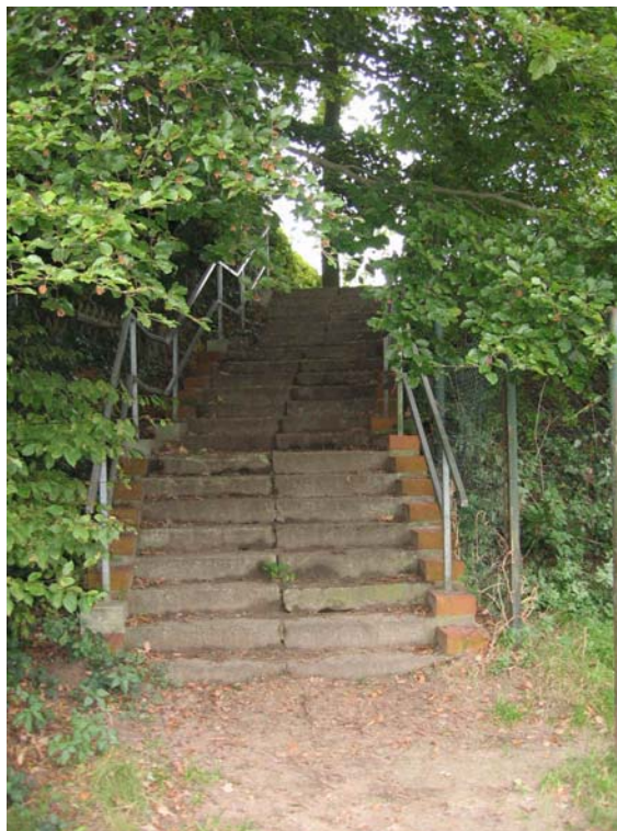
Zugang Bolzplatz Breslauer Straße, Fläche 15
