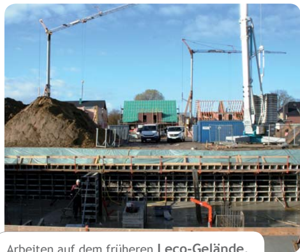
Arbeiten auf dem früheren Leco-Gelände .
