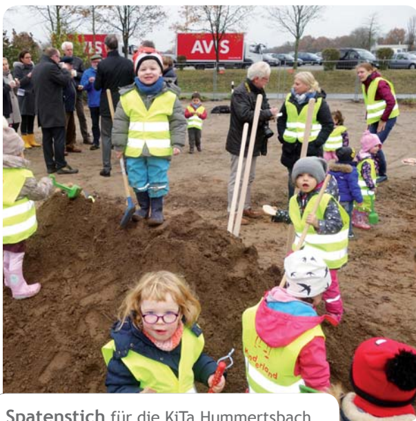
Spatenstich für die KiTa Hummertsbach.
