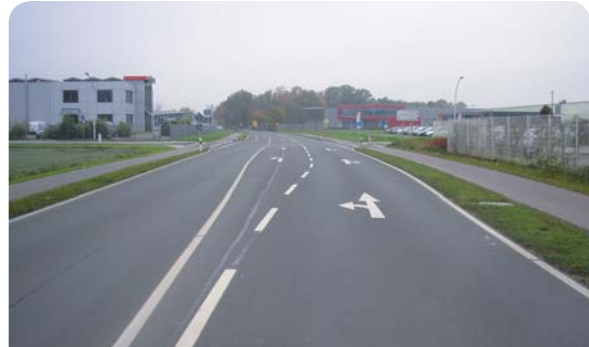
Neue Abbiegespuren zu den Straßen Gutenbergstraße und Senefelder Straße.
